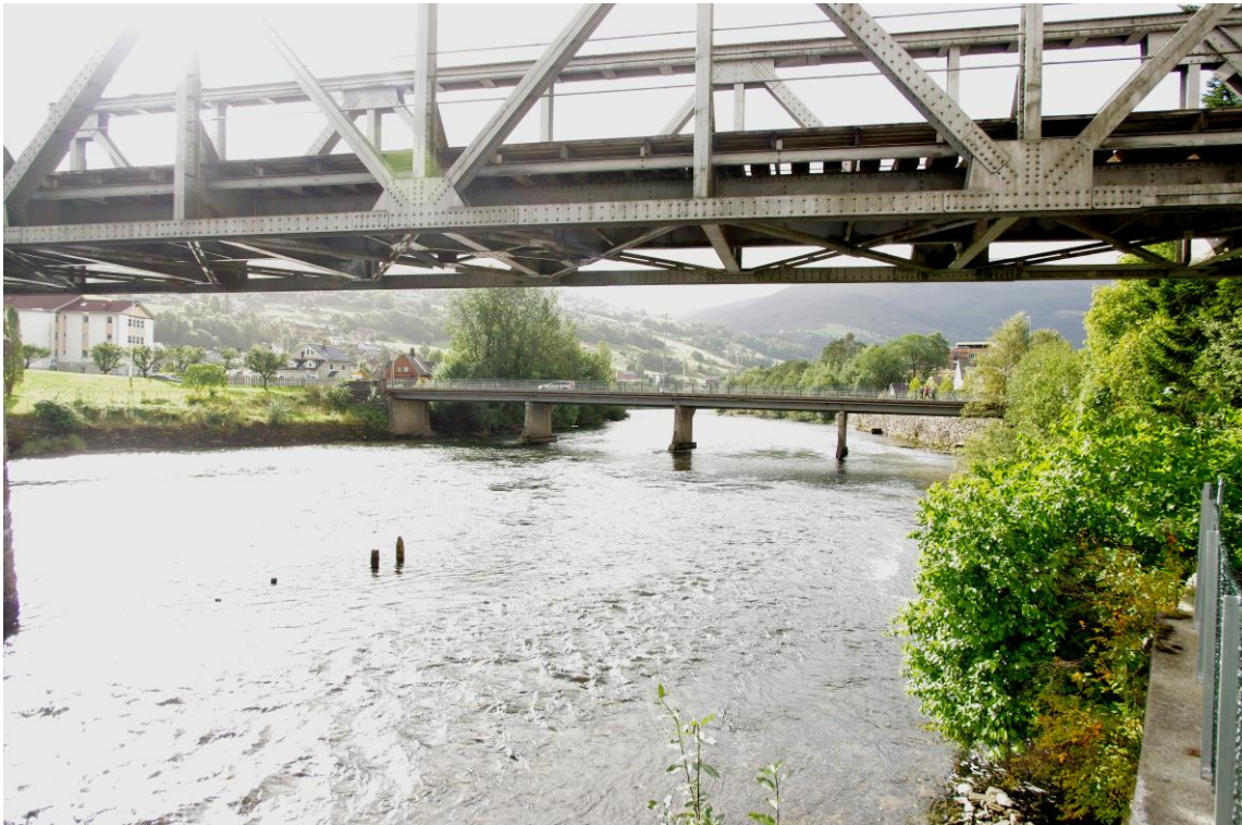
Figur 2-2. Jernbanebrua (fremst) og Langabrua. Foto Nils Roar Sælthun
