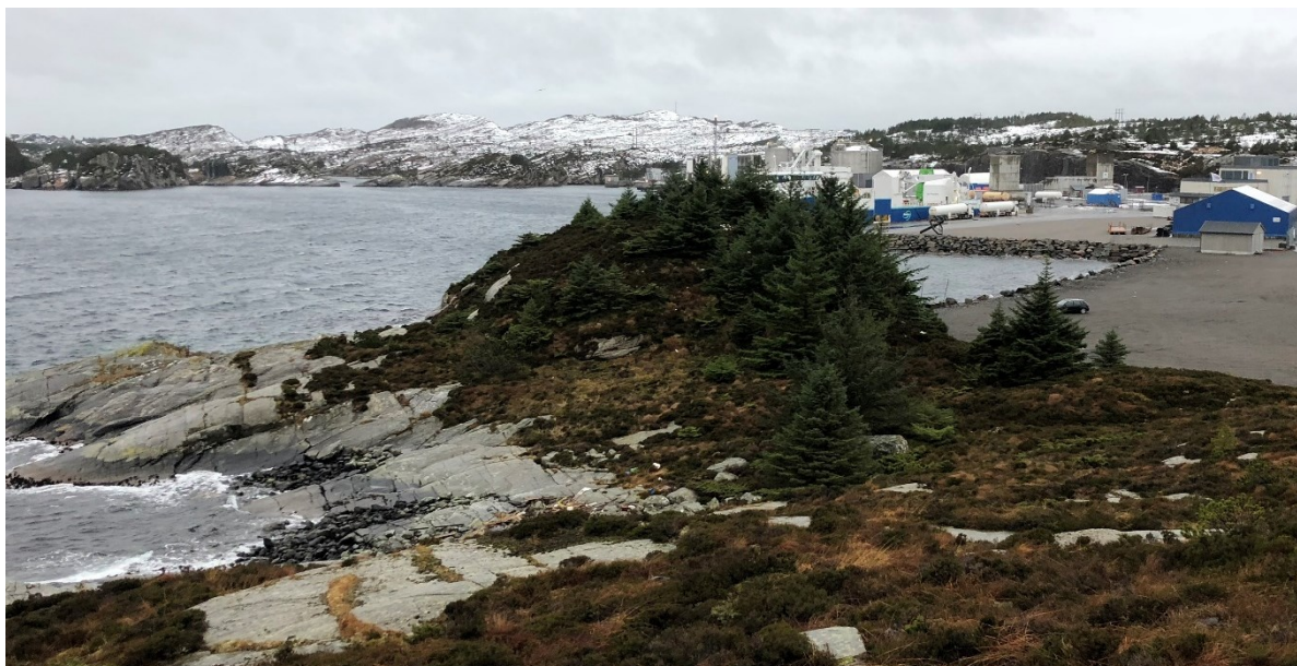
Figur 7-7. CCB Energi sitt anlegg i Ljøsøybukta, fra 2018 før videre utbygging av området med Northern Lights.
