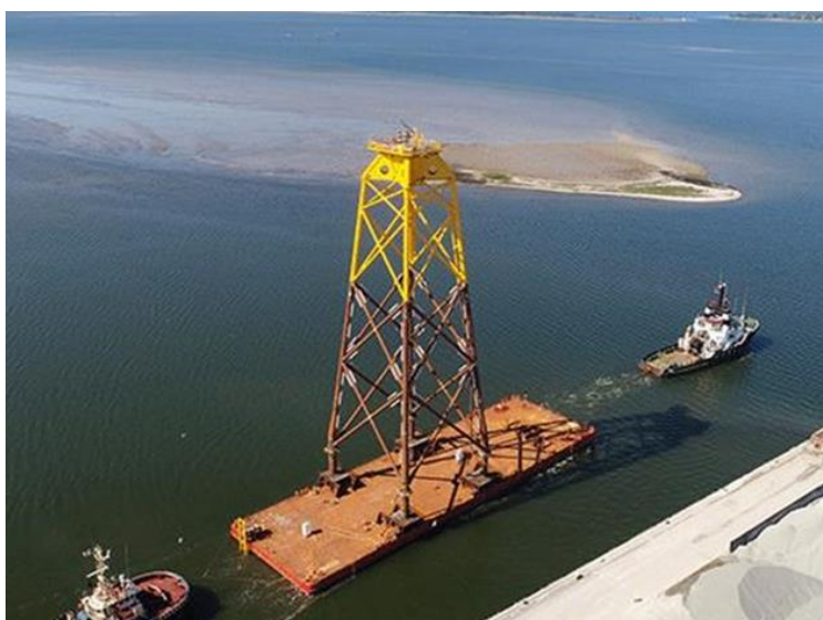
Figur 2-3: «Jacket»-fundamenter i transport fra havn. Kilde: [3].
