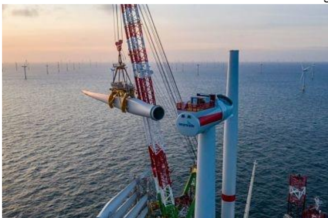
Figur 1-8 Installering av vindturbin
