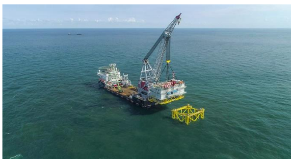
Figur 1-9 Installering av transformatorstasjon
