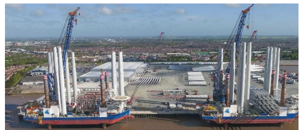
Figur 1-6 Byggehavnen i Port of Hull
