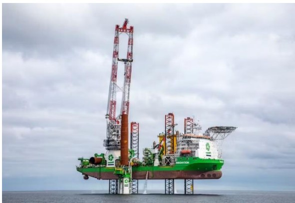
Figur 1-7 Monopælinstallering fra jackup vessel
