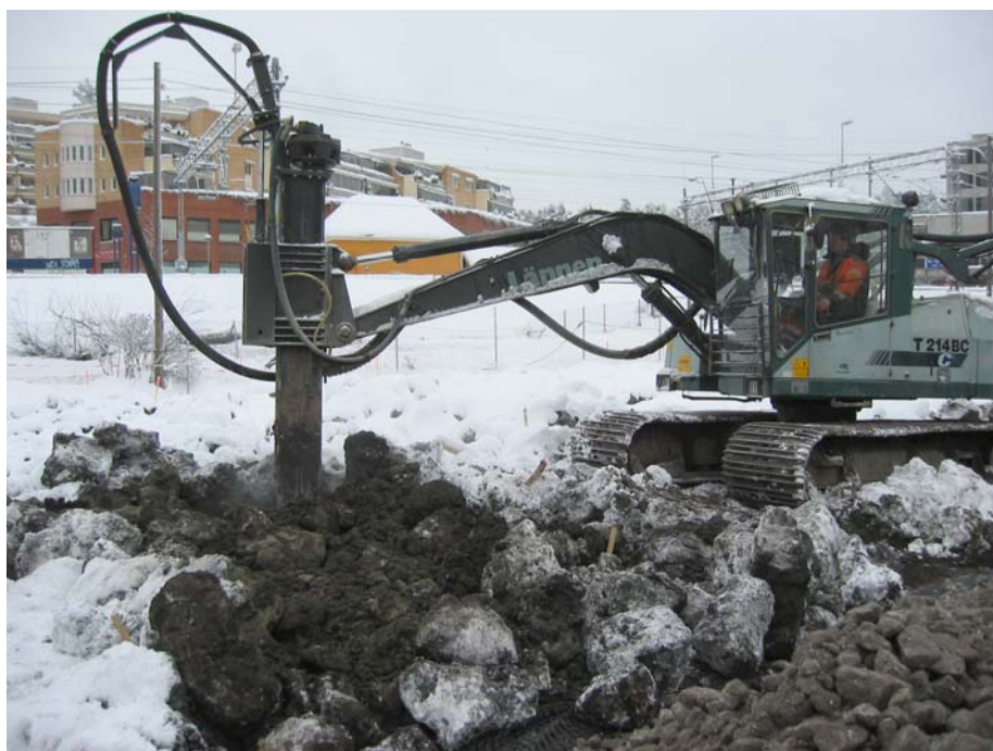
Figur 4.3- Eksempel på utstyr for massestabilisering med kalk/semment
