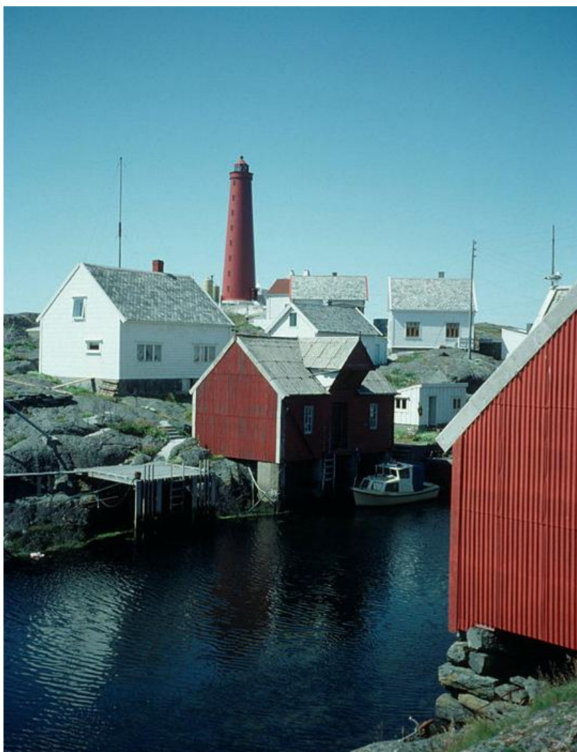
Figur 85 Utvær fyrstasjon i Solund er vedtaksfredet. Foto: Monrad-Krohn Danckert, Riksantikvaren.
