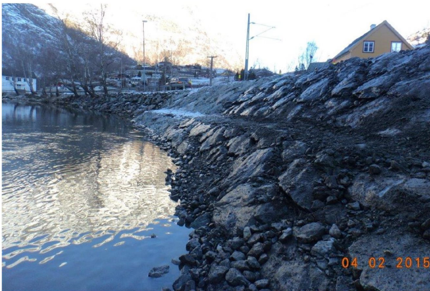
Bilde 6: Plastring ved Samfunnshuset i Flåm. Reparasjon av sikringstiltak 6657 Flåmselvi ved Samfunnshuset.
