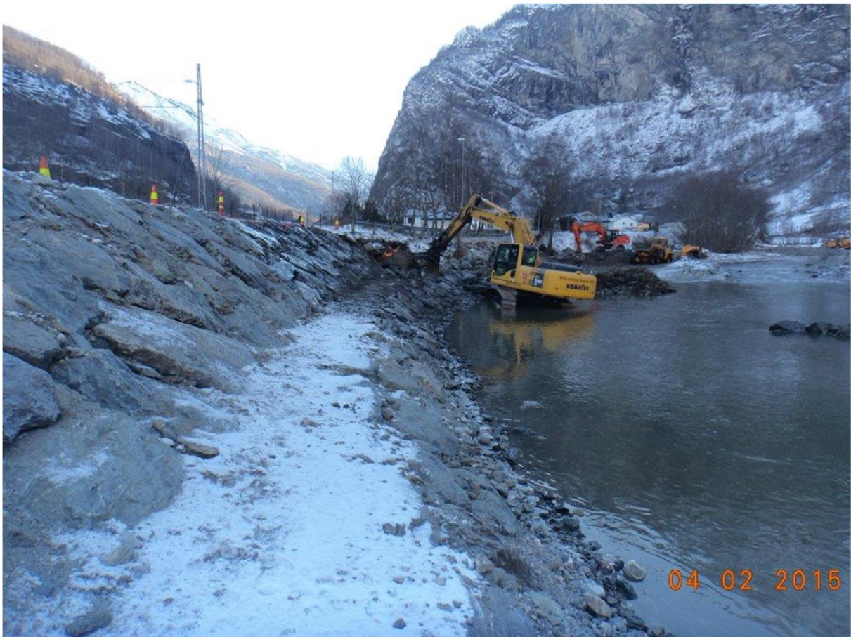
Bilde 5: Plastring mellom Lunden boligfelt og Samfunnshuset, venstre side sett medstrøms.
