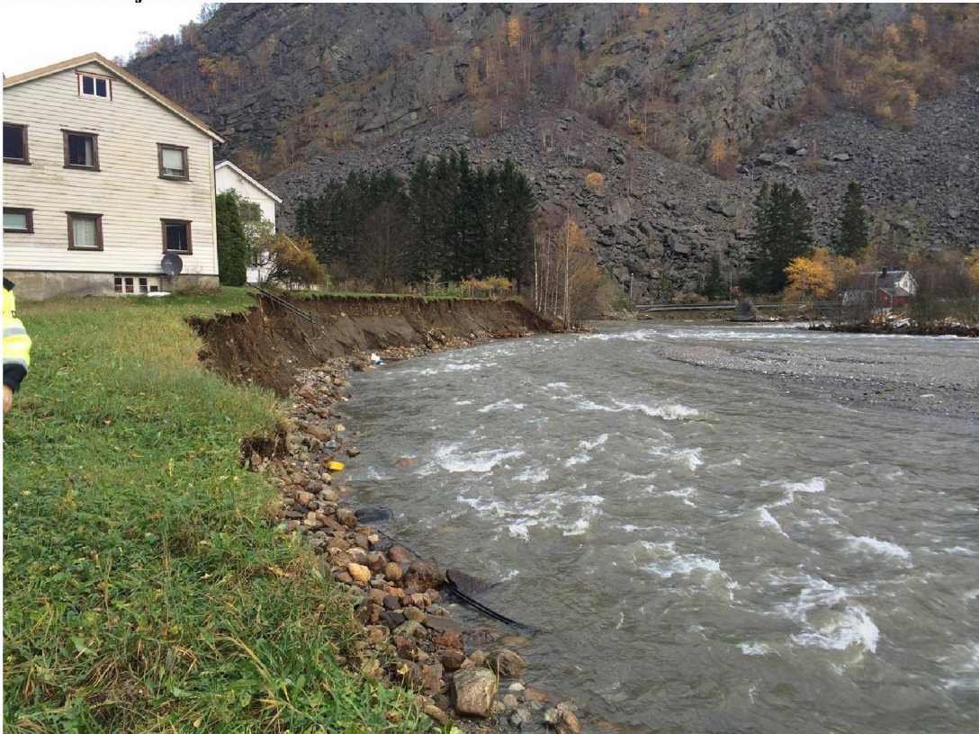
Bilde 4; Erosjonskant langs venstre bredd ved Brekkehagen.
