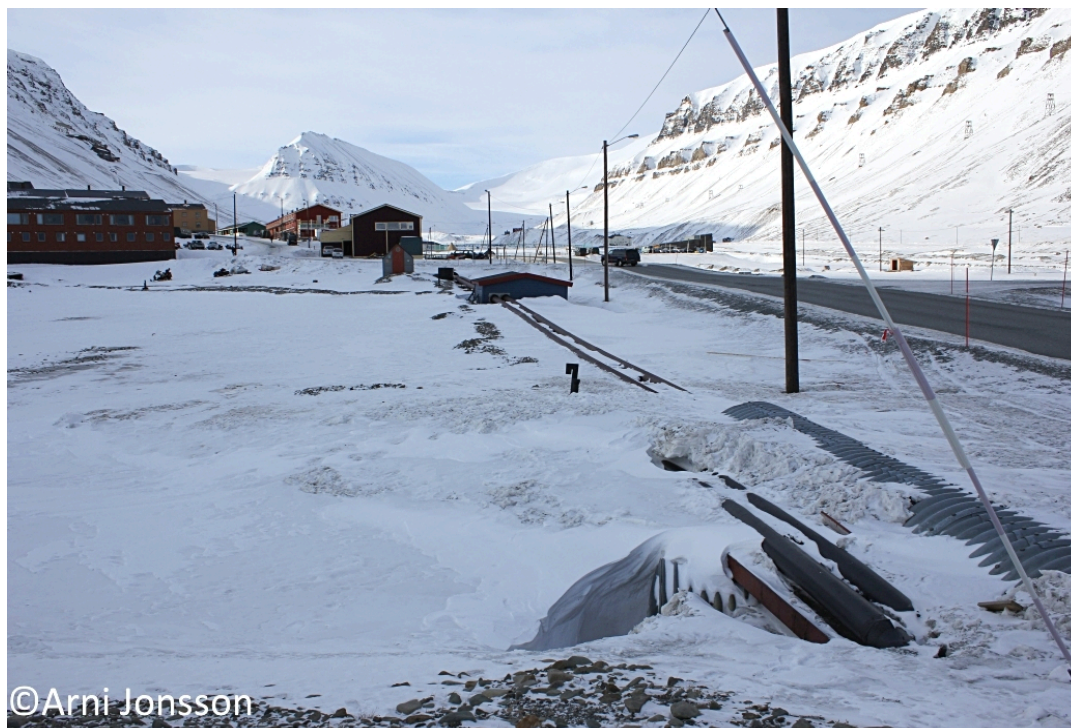
Figur 5. Rørledninger og lysstolper langs vei 500; SV retning.
