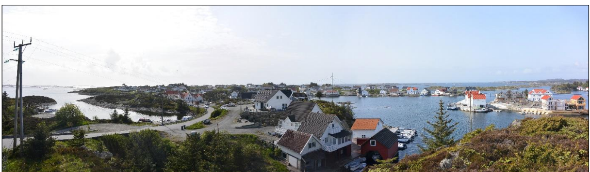
Figur 8-30. Foto som viser eksisterende situasjon sett fra Salvøy mot vest.
