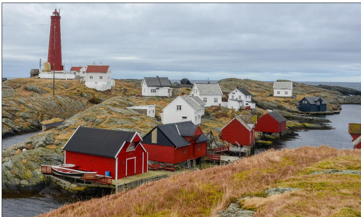
Figur 6-5. Foto som viser eksisterende situasjon på Utvær sett fra en høyde ovenfor bebyggelsen (foto: Stig Steinsund).
