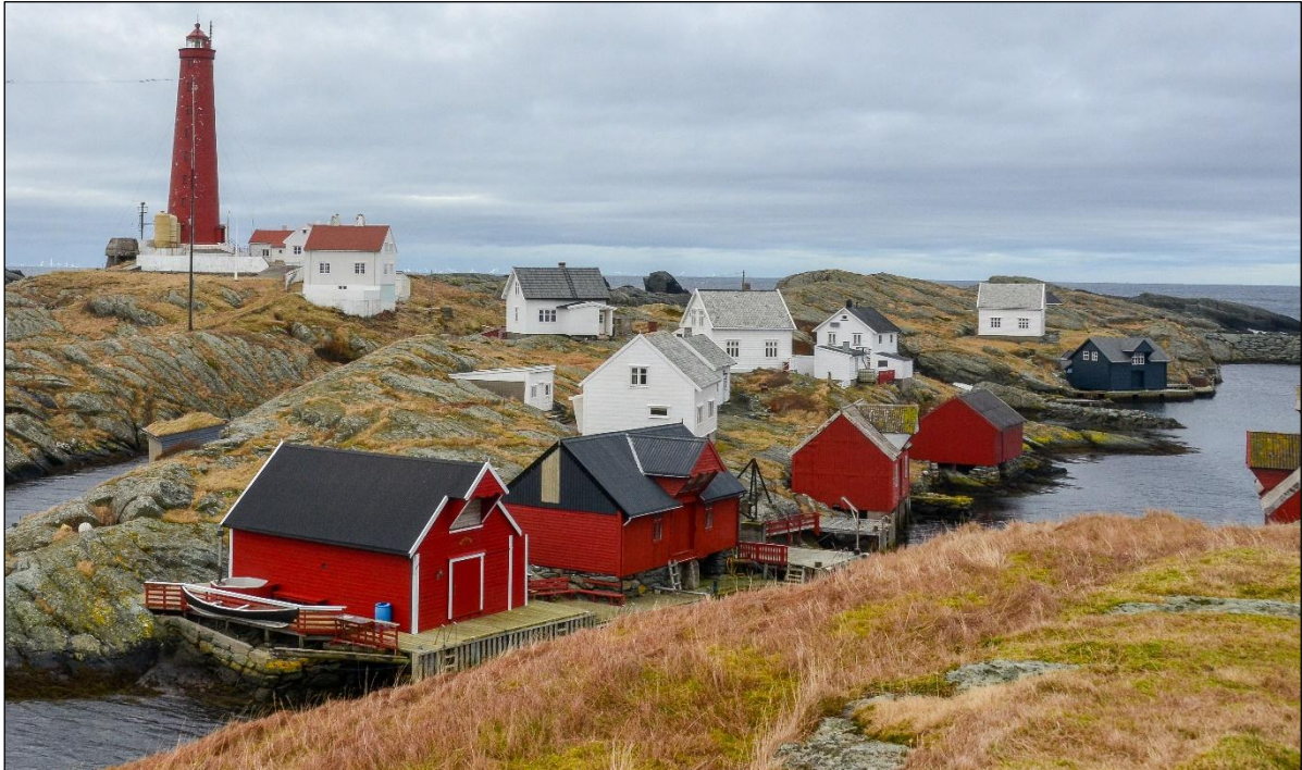
Figur 6-6. Visualisering av en full utbygging av Vestavind B sett fra en høyde ovenfor bebyggelsen, som ligger skjermet for utsyn (foto: Stig Steinsund).
