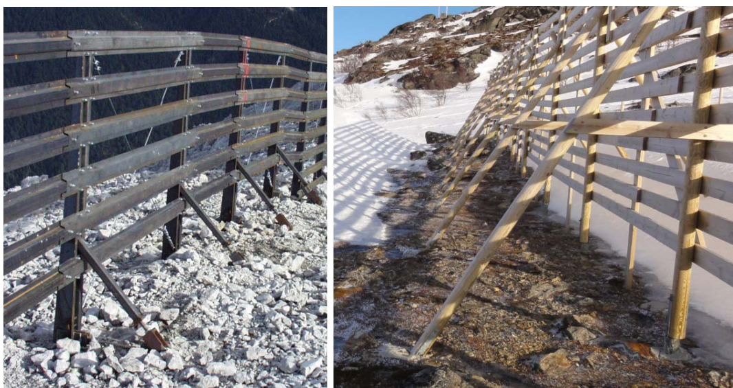
Figur 7. Til venstre snøsamleskjerm i stål ved Hohe-Munde over Telfs i Østerrike (Foto NGI/ Árni Jónsson) og til høyre snøsamleskjerm i tre i Hammerfest (Foto NGI/ Árni Jónsson).
