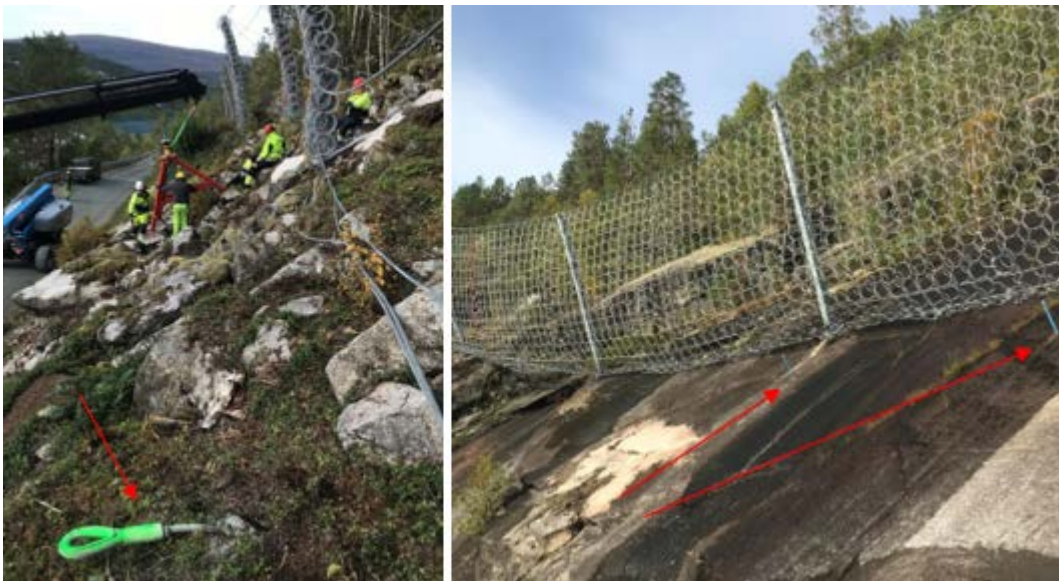
Figur 28. Forankringer for prøving kan etableres utenfor konstruksjonen slik at dimensjonerende kapasitet kan testes (Foto NGI/Henrik Langeland).
