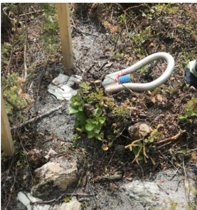
Figur 12. Til venstre selvboende stag benyttet som forankring i jord/løsmasse for kabler med bremseelement i steinspranggjerde (Foto NGI/Henrik Langeland).
