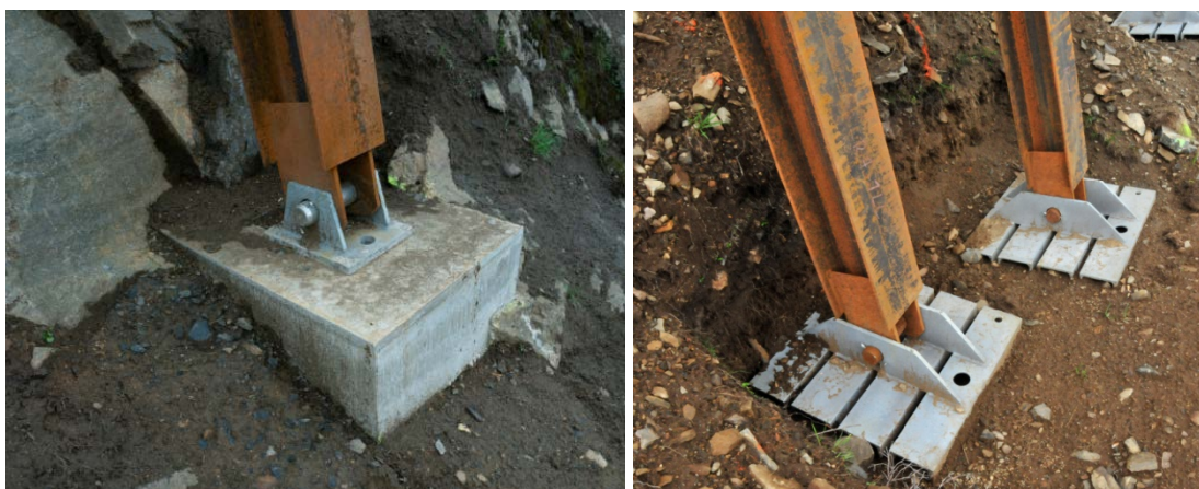
Figur 6. Til venstre vises fundament for feste av støtte på berg der betongfundamentet støpes rundt innstøpte bolter i berg (Foto NGI/Henrik Langeland). Til høyre vises støtteplate i jord/løsmasser med hull klart for forankring av fotplaten (Foto NGI/Henrik Langeland). Dette samsvarer med forankringspunkt D i Figur 4.
